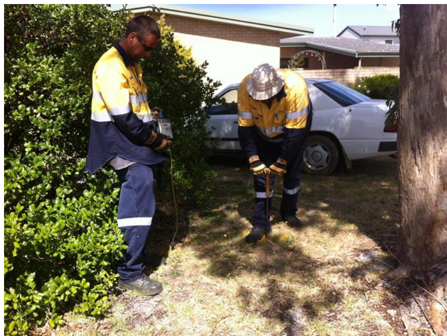
Albany: Potholing Survey
