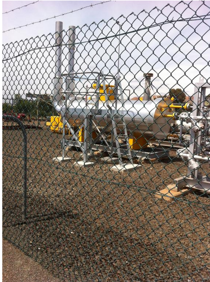
Kalgoorlie: New Water Bath Heater
